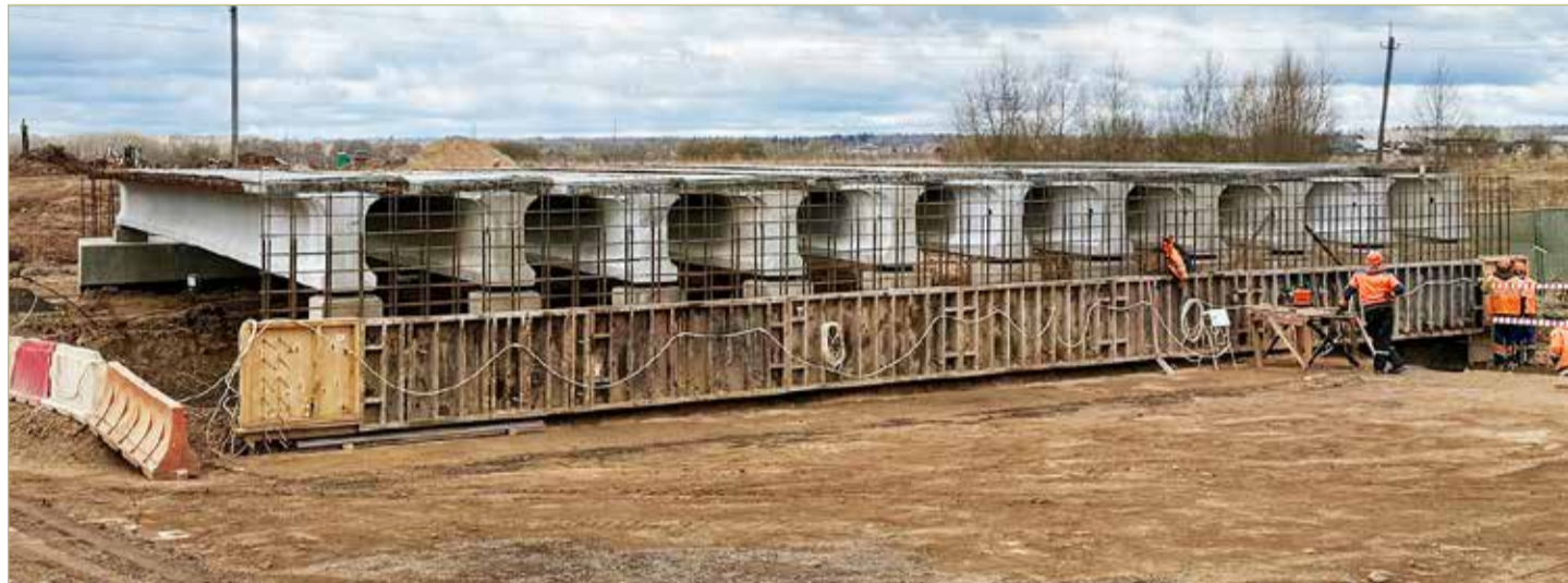
Длина будущего моста через реку Веряжу составит более 36 метров.
